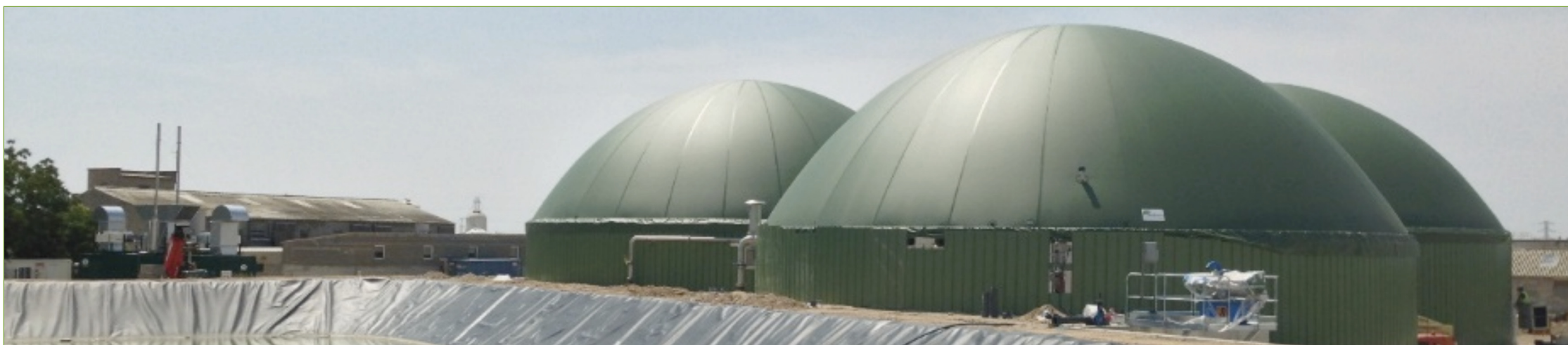
Planta de biogás de Torregrossa.
