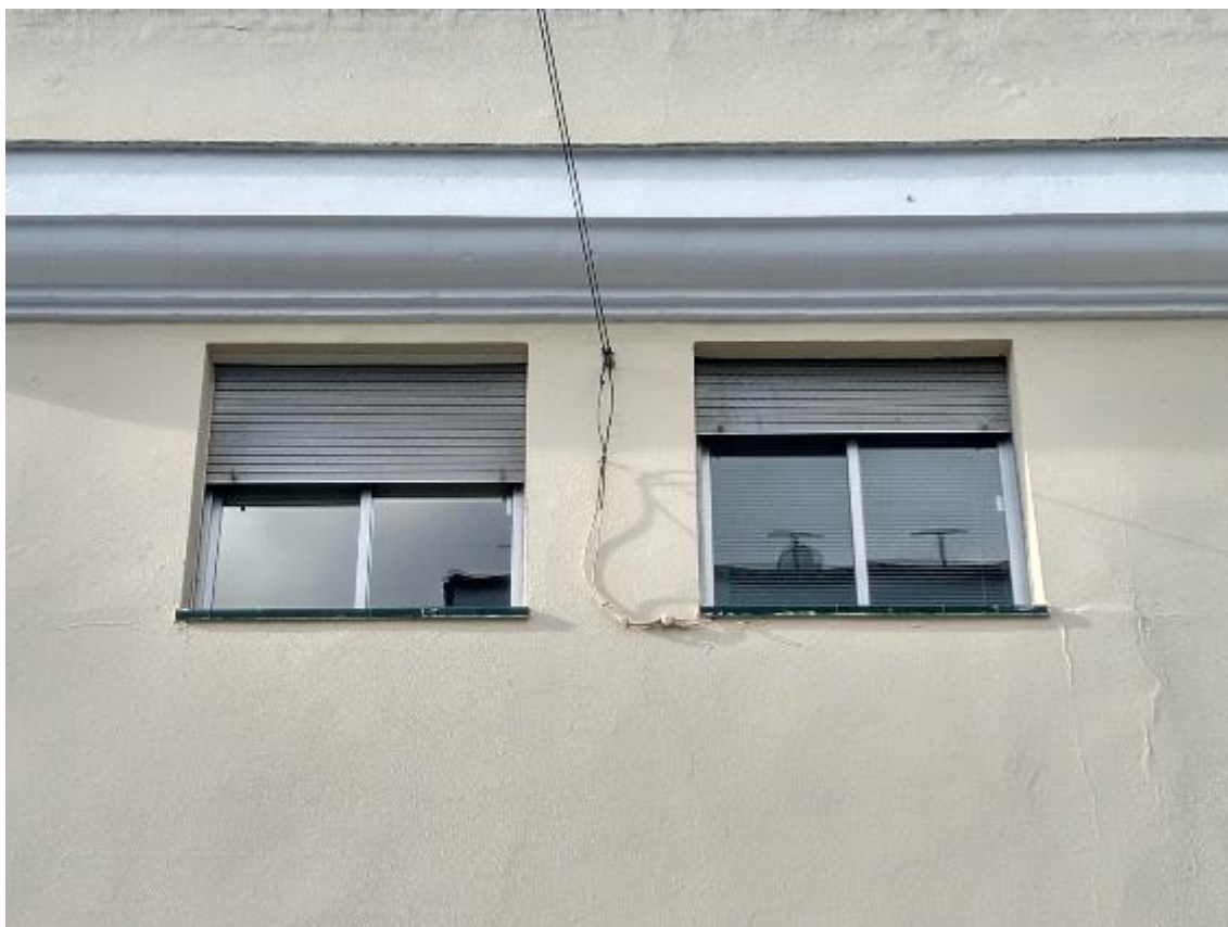
Figura 17. Comparación de ventanas. La derecha tiene acceso libre al bombo de la persiana, mientras que la izquierda tiene una barrera para impedir el acceso a vencejos y murciélagos.
