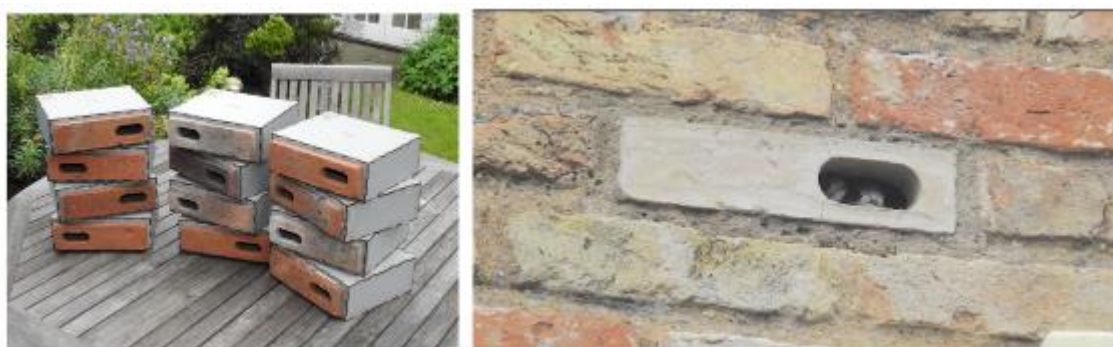
Figura 23. Ladrillos de vencejos o S-bricks integrados en la fachada.
