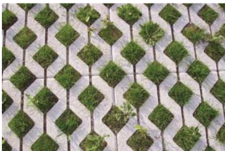
Figura 28. Entre el suelo de adoquines hay espacio suficiente para pequeñas zonas sin impermeabilizar por dónde drena el agua.
