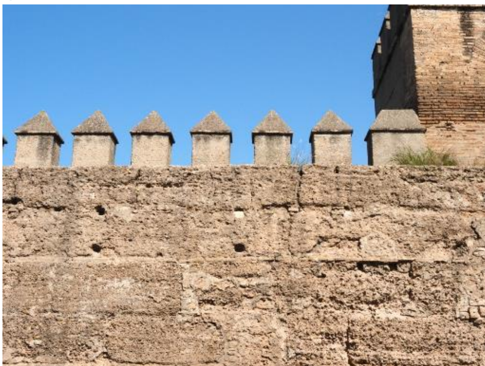
Figura 20. Mechinales adaptados a la derecha, aún están frescos y por tanto el color es más claro, pero la mezcla se va oscureciendo con el tiempo de forma que no tiene ningún impacto visual.
