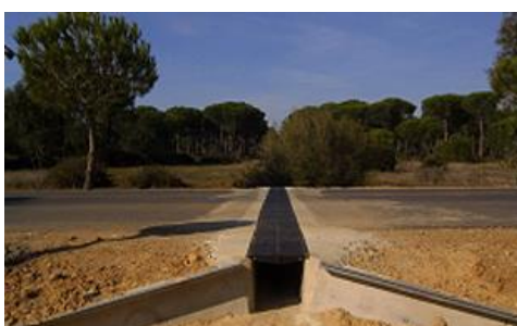
Ilustración 12. Paso de anfibios en la carretera Almonte-Los Cabezudos.
