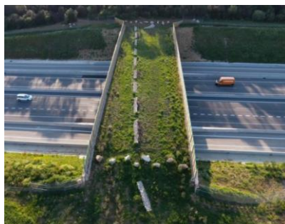
Ilustración 10. Paso superior de fauna en la A2. Fuente: www.censolaboiberico.org
