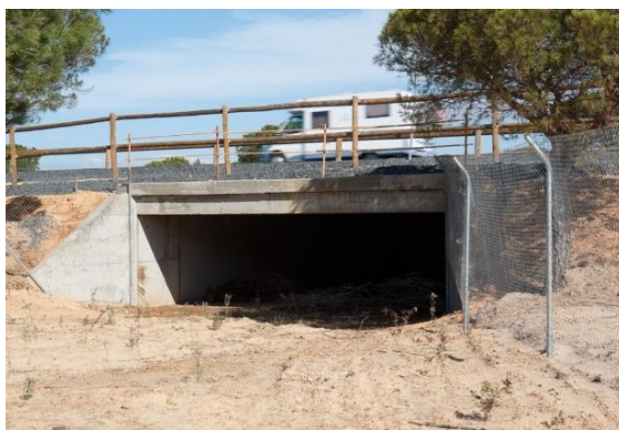
Ilustración 11. Paso inferior específico para fauna en el Parque Nacional de Doñana.
