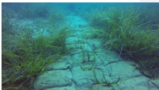
Ilustración 37. Plantación de posidonia oceánica sobre sacos rellenos para consolidar el sustrato.
