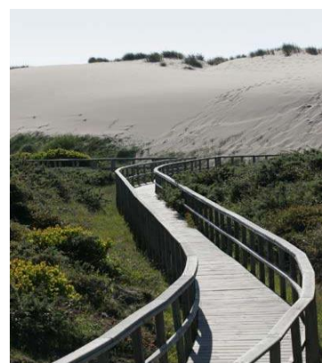
Ilustración 33. Pasarela con cerramiento, playa de Salinas, Avilés. (Principado de Asturias). Fuente: www.vilescomarca.info
