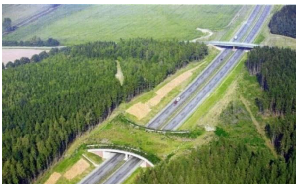
Ilustración 9. Ecoducto de la carretera A-66, entre Benavente y León. Fuente: www.ideasverdes.es
