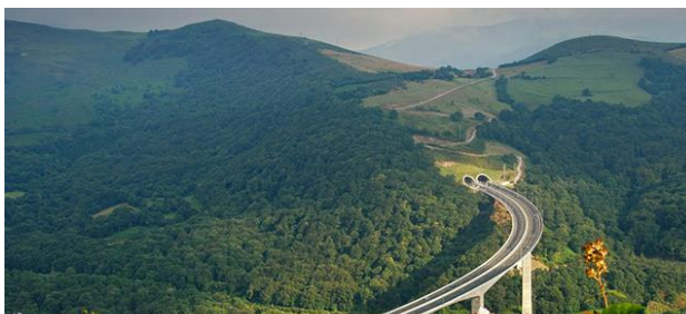
Ilustración 8. Viaducto y túnel de la carretera A67. Fuente: www.mosingenieros.com
