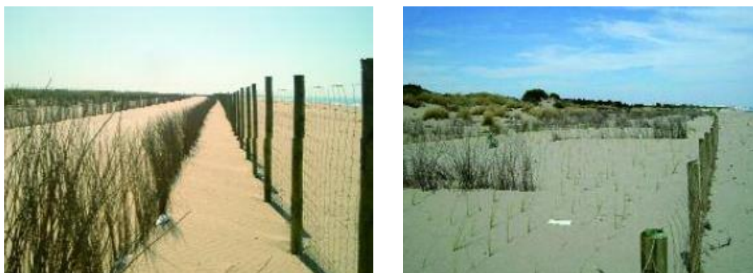
Ilustración 32. Captador estructural (izquierda) y captador de apoyo (derecha).
