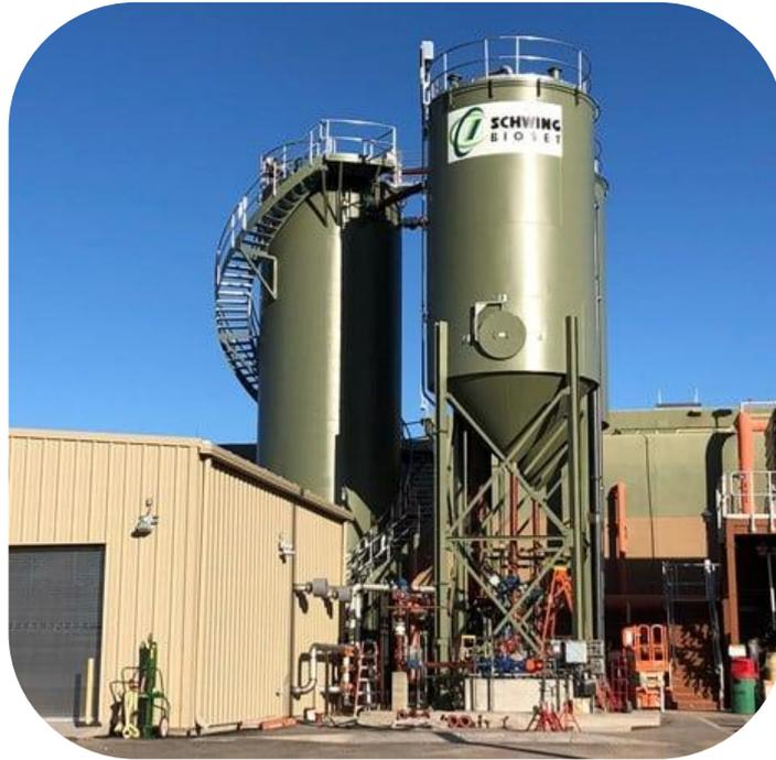
Figura 49. Cristalizador a escala industrial.
