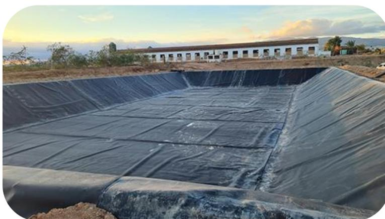
Figura 33. Balsa de purines sellada con membrana geotextil.
