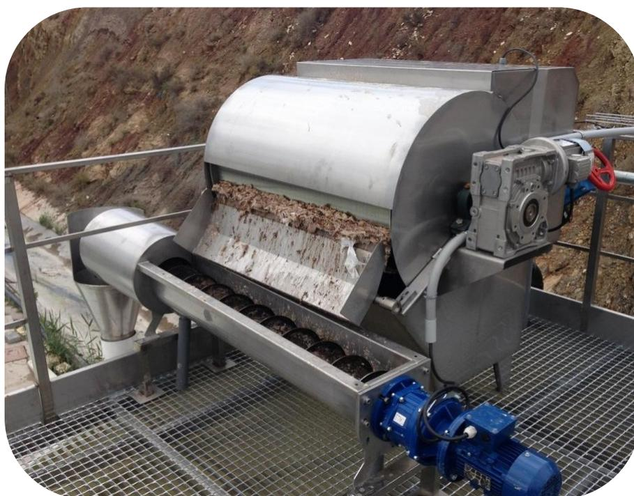
Figura 47. Tamiz autolimpiante con tornillo sin fin.
