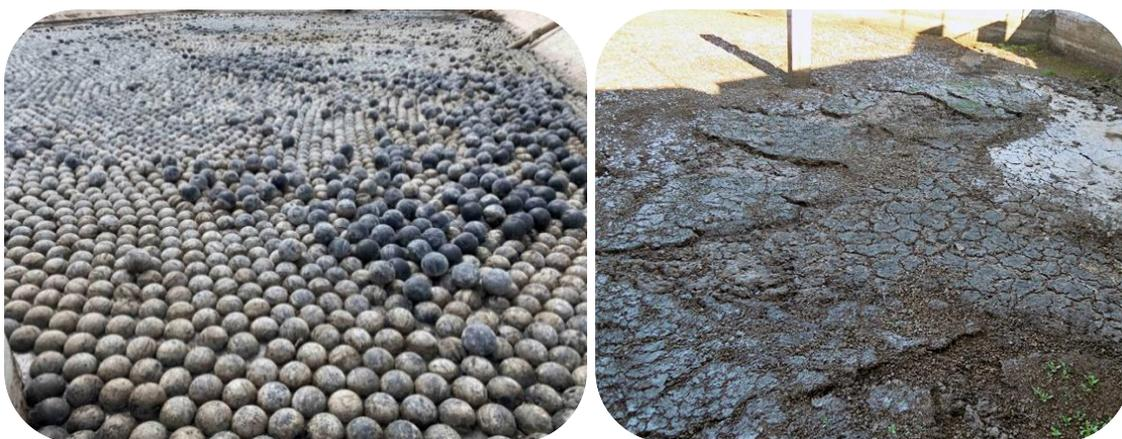
Figura 30. Cubierta flotante de esferas (de panal flotante) y costra natural generada en la superficie de una balsa de purines.
