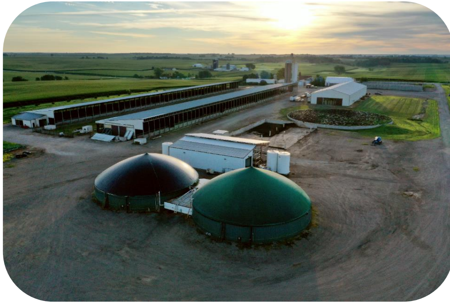
Figura 39. Digestores instalados en una granja. Fuente: Agricultural Marketing Resource Center.
