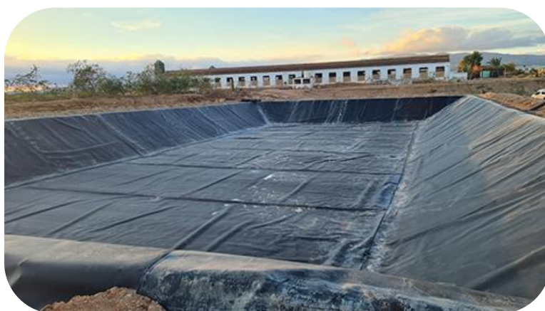
Figura 33. Balsa de purines sellada con membrana geotextil. Fuente: IMCUR .
