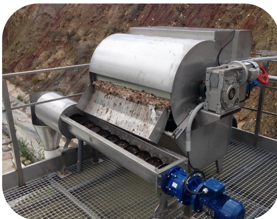
Figura 47. Tamiz autolimpiante con tornillo sin fin. Fuente: Miraplas.
