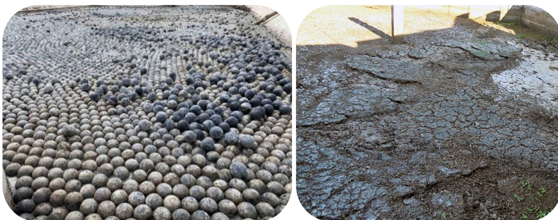
Figura 30. Cubierta flotante de esferas (de panel flotante) y costra natural generada en la superficie de una balsa de purines.
