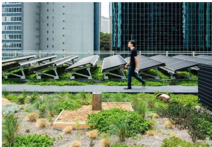
Figura 17. Tejado con instalación fotovoltaica en el centro de Sídney, cubierto de hierbas y plantas autóctonas. Fuente: Clean Energy Council.
