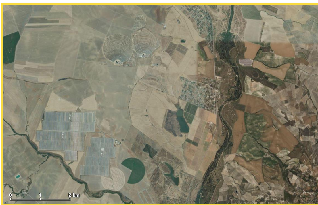
Figura 9. Planta fotovoltaica Solnova y Torres Solares de Abengoa en Sanlúcar la Mayor (Sevilla). Fuente: Imagen satelital de Maps Apple.
